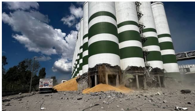
Рис. 1. Последствия взрыва зерновой пыли в элеваторе
