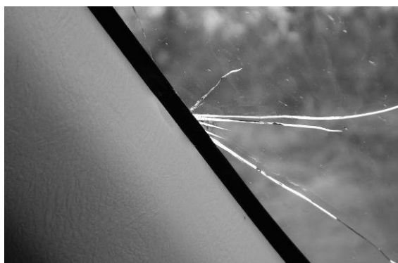
Рис. 7. Образование веера трещин от дефекта кромки
